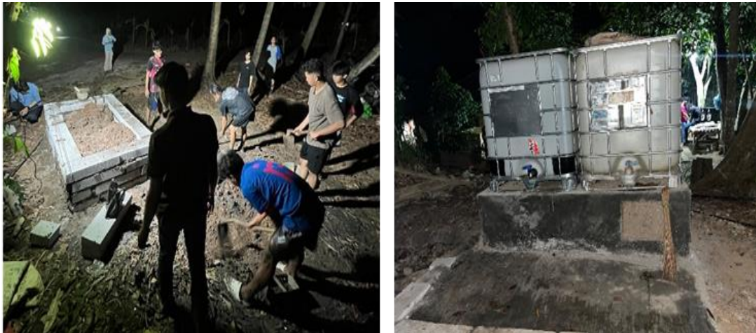
Gambar 2: Proses Pemasangan Tandon
